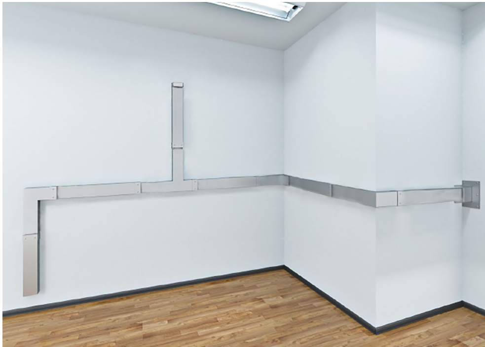
Prinzipieller Aufbau mit geraden Kanalelementen und Formteilen
